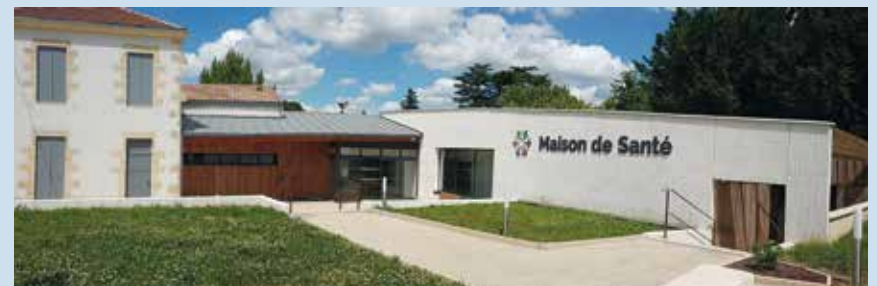
La maison de santé de Gensac.
